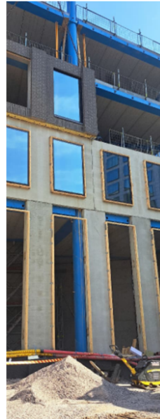
Päällekkäinen työskentely elementtiasennus / maanrakennus 9/2025
