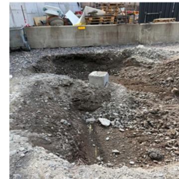
Torninosturin sähkökaapelin katkaisu lyöntipaaluttamalla 5/2026
